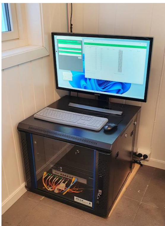
Eksempel på rack med USP, Server og fiberadapter. WiFi-antenne utenmdørs.
