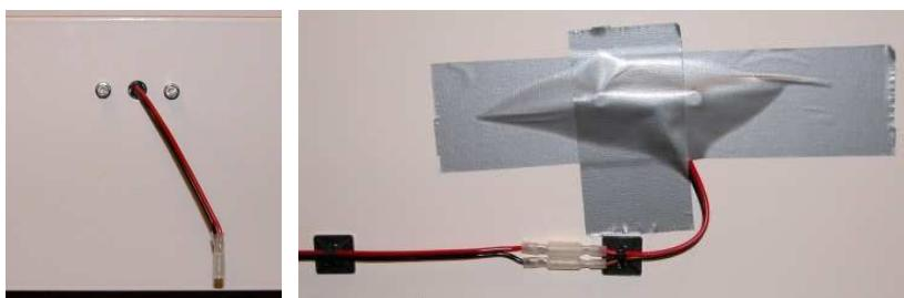
Bruk sølvtape for å dekke til hull og muttere på baksiden.
